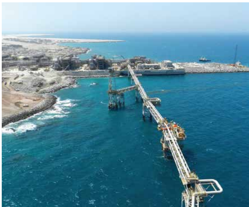
Haventerminal en zeewaterinlaat, Das Island, Abu Dhabi, VAE
