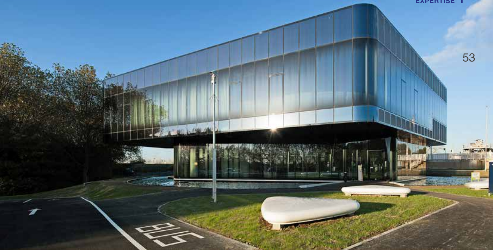
Regiocentrale-Zuid, Maasbracht, Nederland, Architect: Wiel Arets
