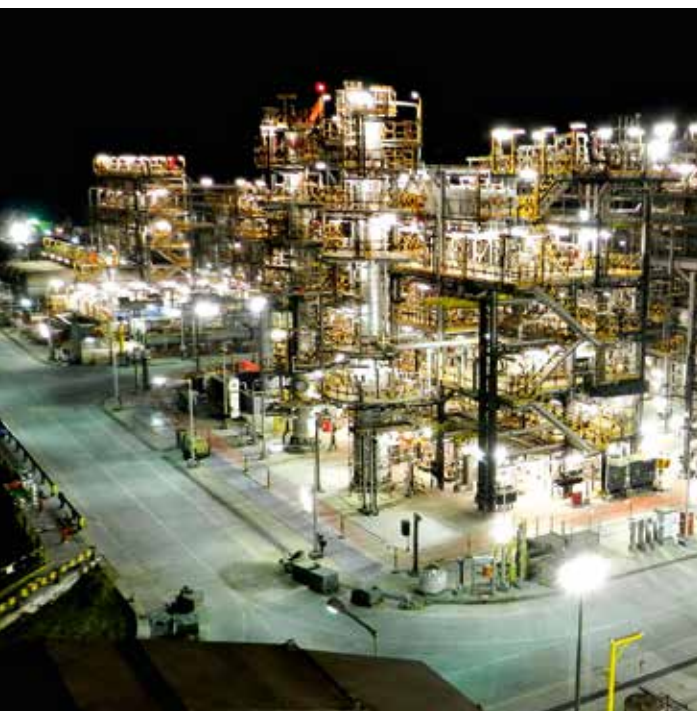
Haventerminal en zeewaterinlaat, Das island, Abu Dhabi, VAE
